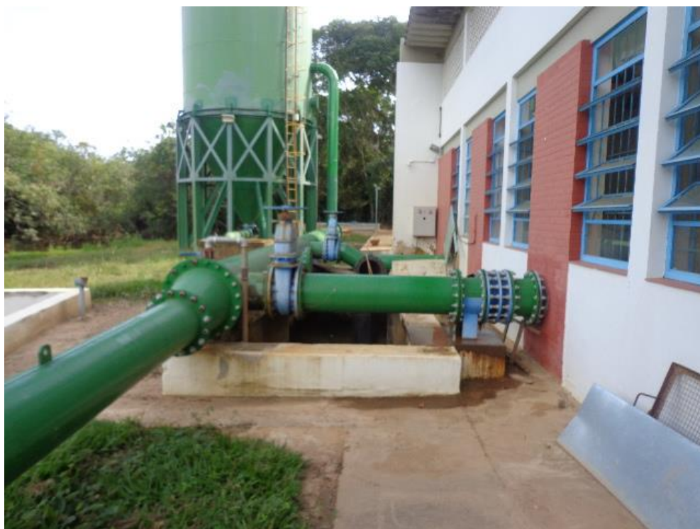
Foto 07. Barrilete de Sucção(reservatório 300m³).
