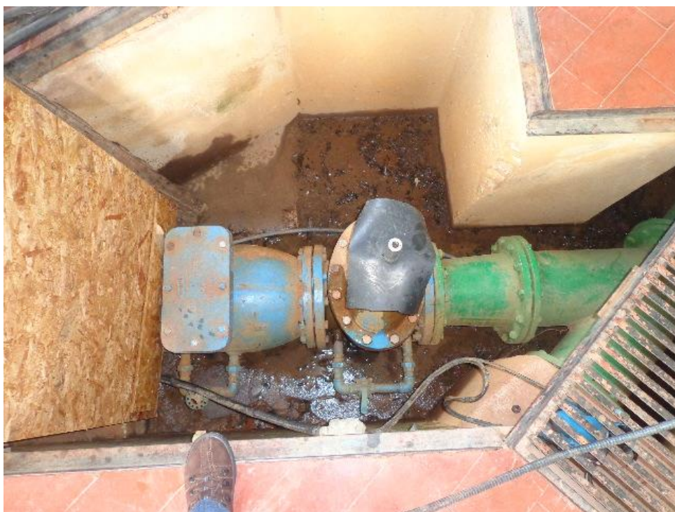
Foto 09. Limitroque-valvula de retenção.
