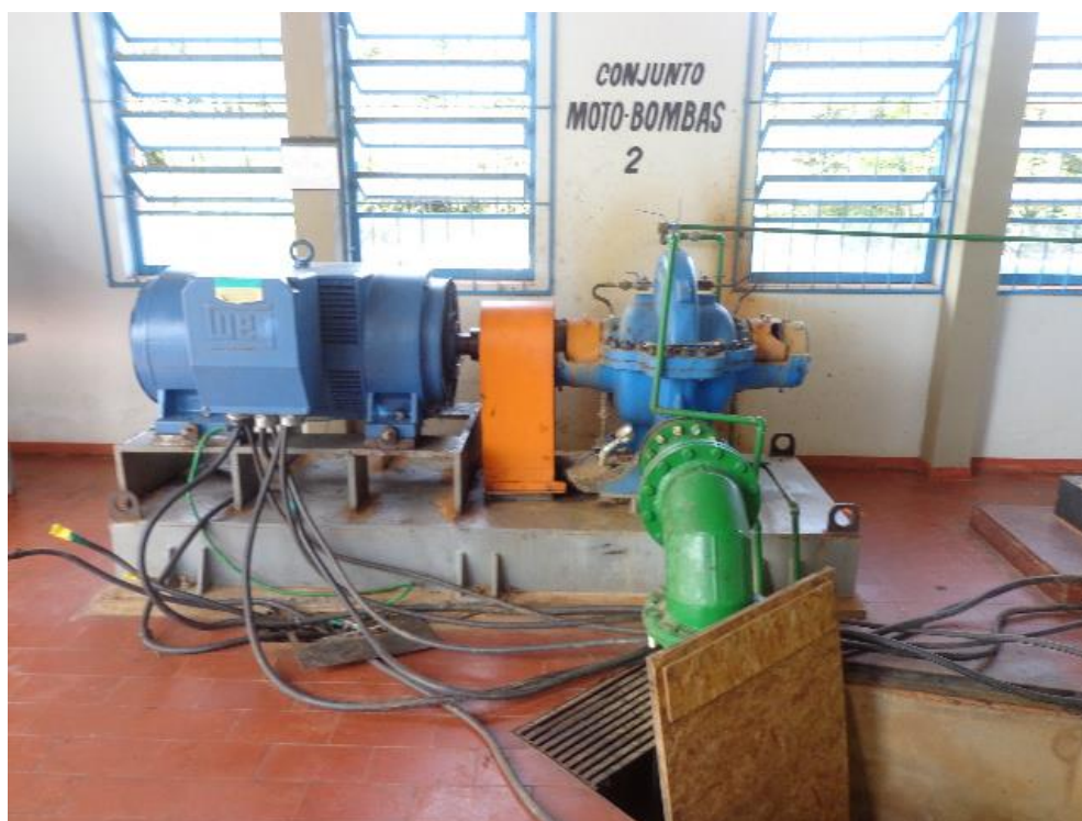
Foto 08. Bombas (550cv/600cv).
