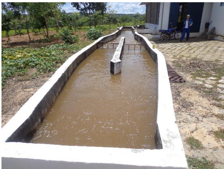
Foto 04. Calha Parshall Pari.
