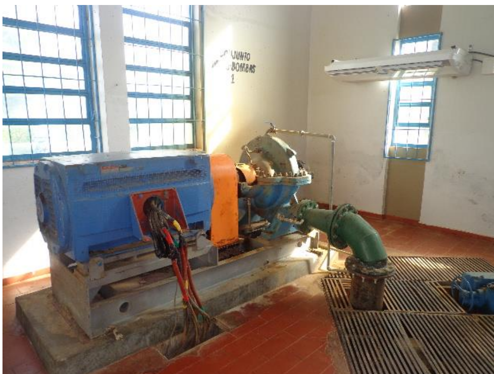
Foto 11. EAB02 Bombas (500cv/550cv).
